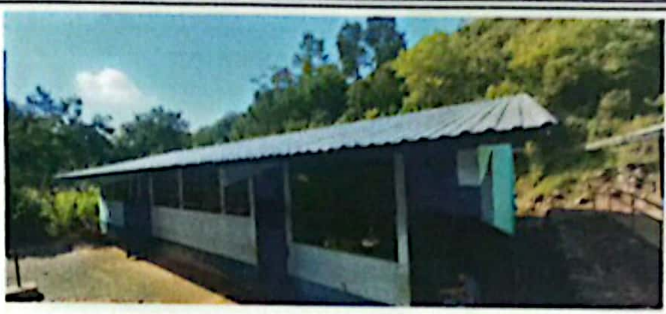
FINALIZACION CUBIERTA Y ESTRUCTURA DE TECHO DEL ESTABLECIMIETO
