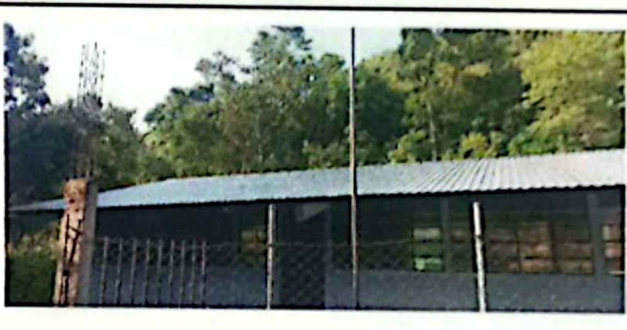
COLOCACION DE TECHO DEL CENTRO EDUCATIVO DE A EORM SEPAJCH II
