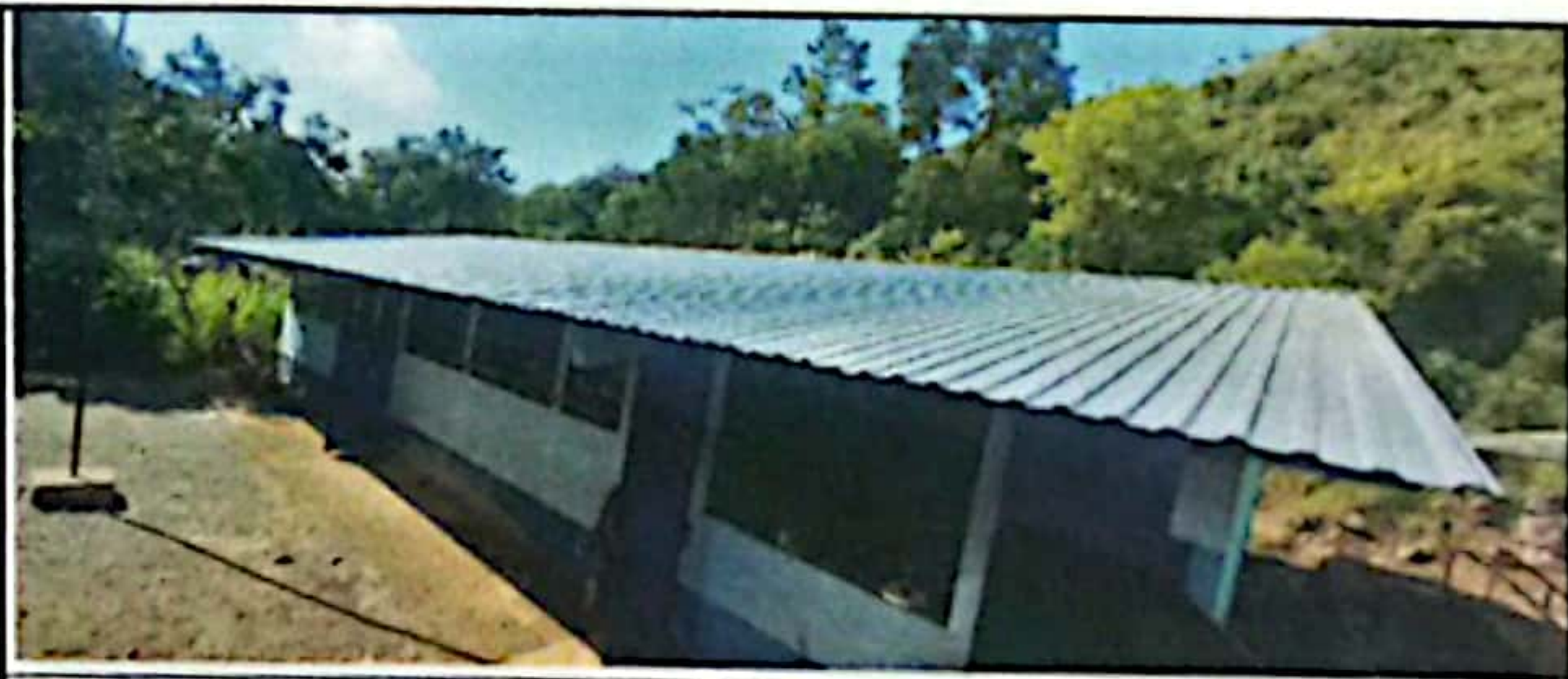
FINALIZACION DE CAMBIO DE TECHO DE LA EORM SEPAJCH II
