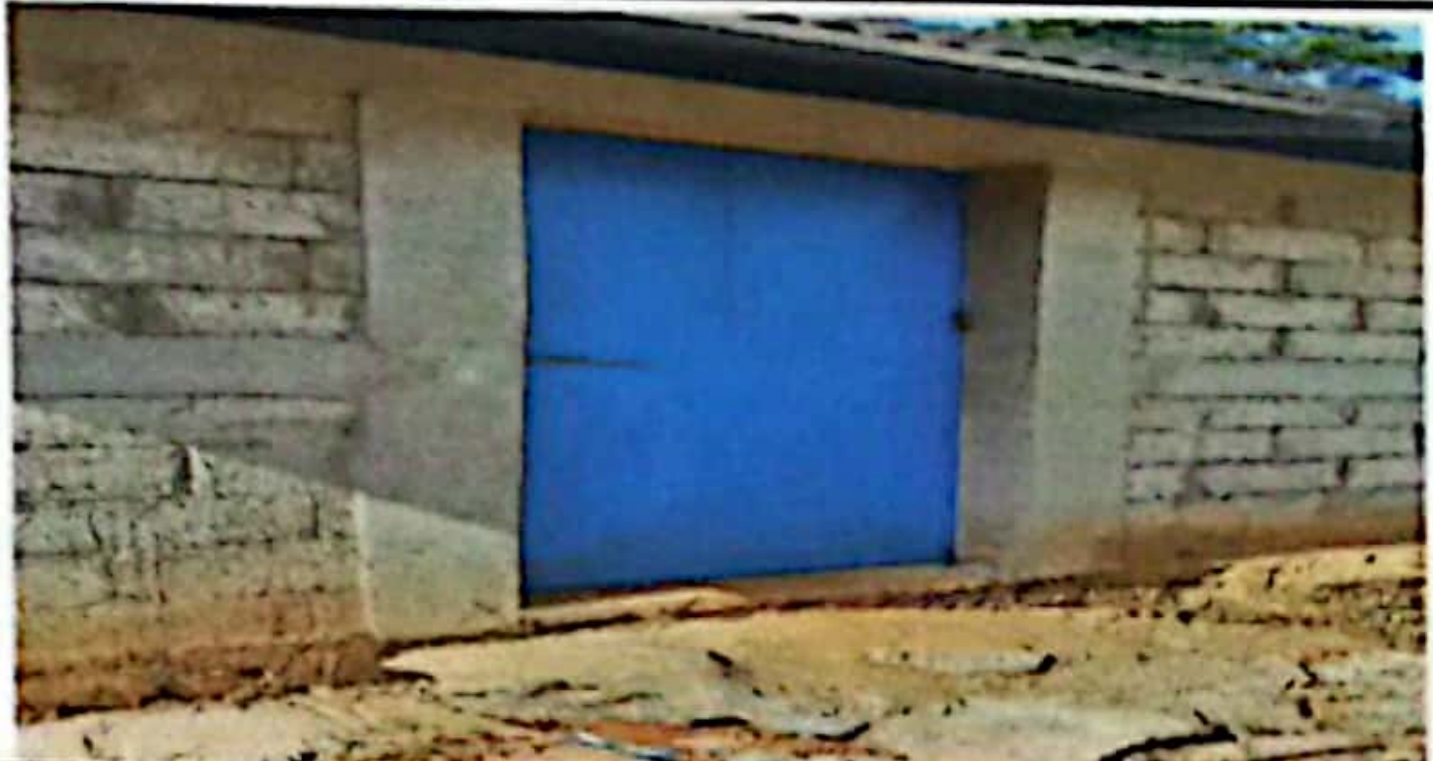
COLOCACION DE PUERTAS DE LA COCINA DE LA EORM SEPAJCH II
