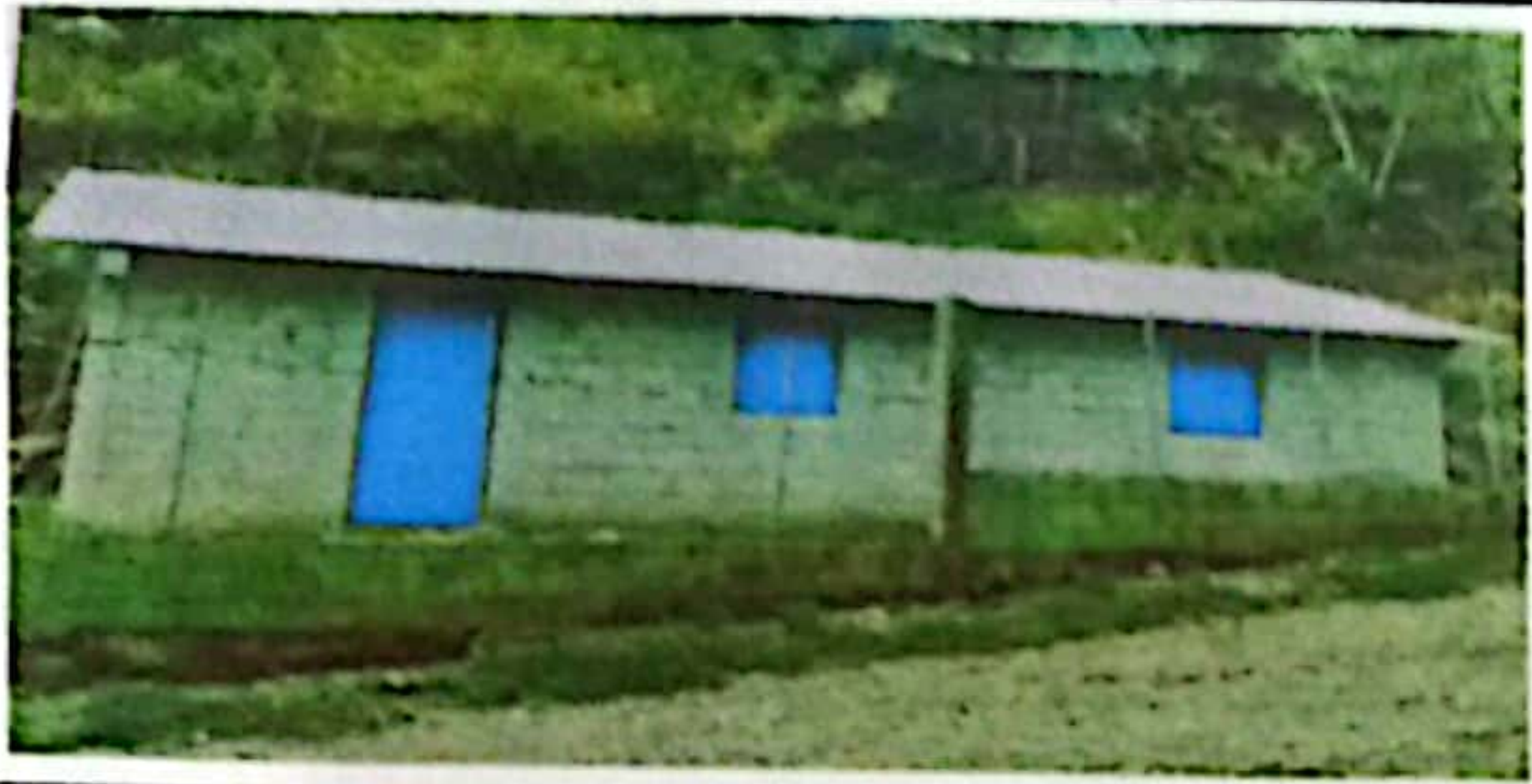
FINALIZACION E INTALACION DE PUERTAS DE METAL Y VENTANAS DE MASETAL CUBIERTA DE LAMINA Y ESTRUCTURA DE TECHO MODULO 1
