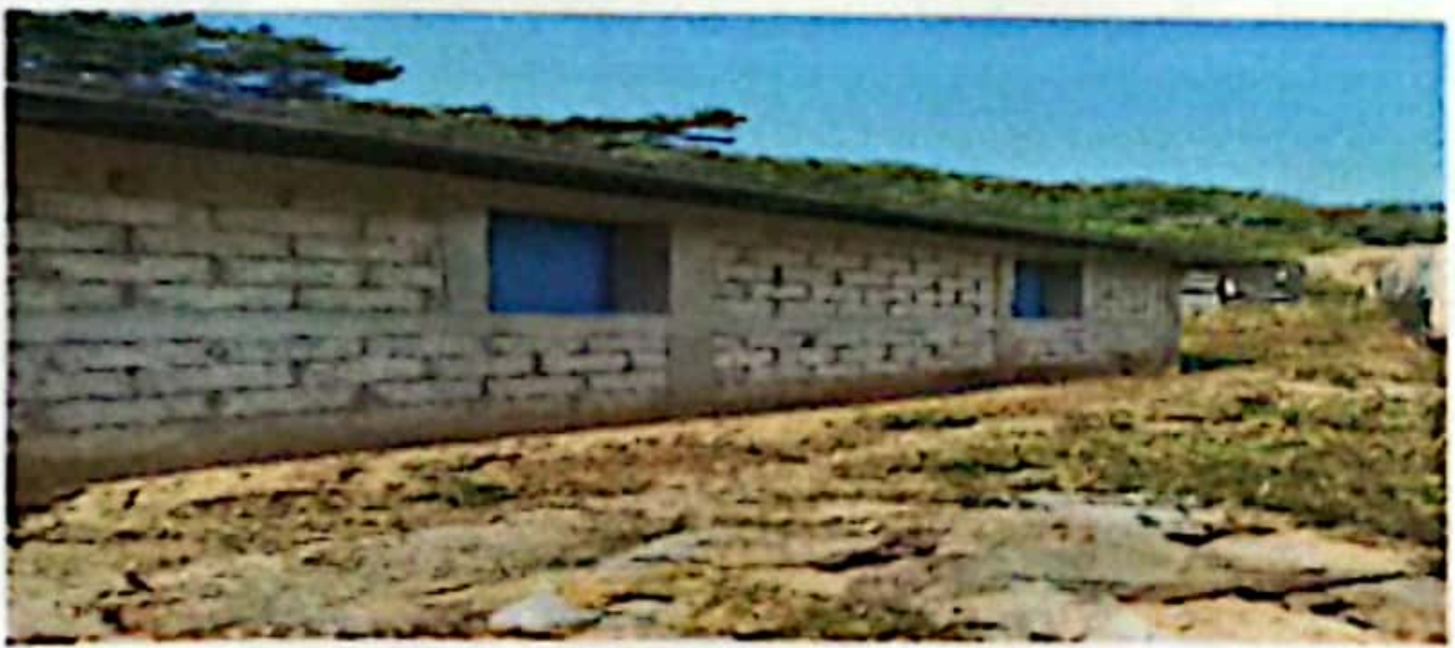
COLOCACION DE VENTANAS DE LA COCINA DE LA EORM SEPAJCH II
